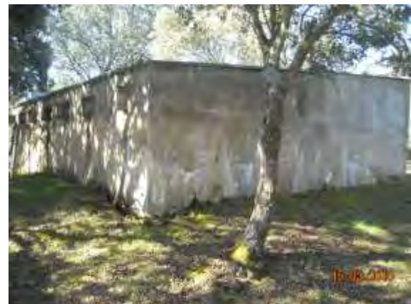
Vista lateral del depósito
