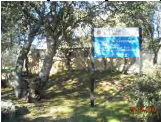
Vista del depósito
