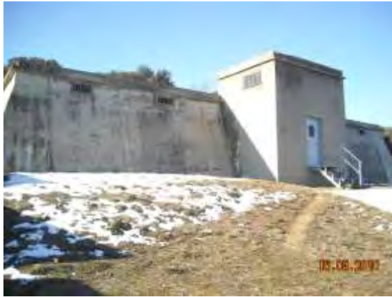
Vista del depósito
