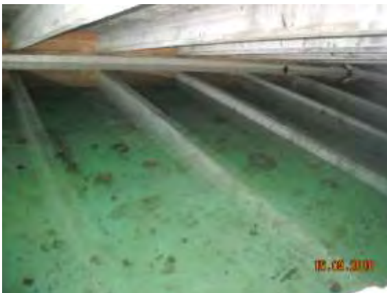
Vista interior del depósito
