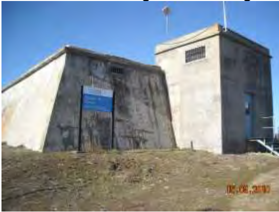
Vista del depósito
