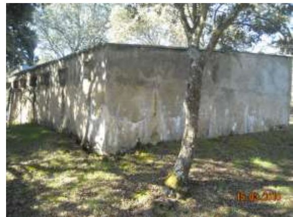
Vista lateral del depósito
