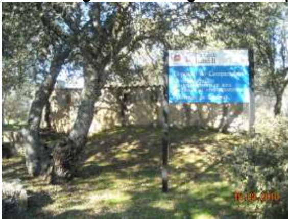
Vista del depósito
