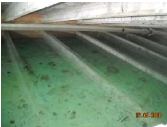
Vista interior del depósito
