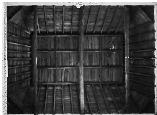
11. Crucero de la iglesia del convento de San Francisco en Betanzos. Construida en el siglo XIV responde al esquema de par y nudillo típico de nuestra carpintería histórica.
