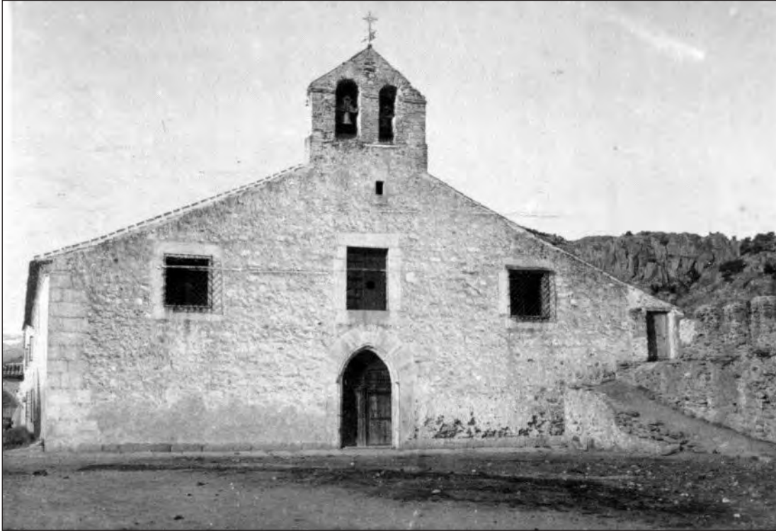
1. Buitrago del Lozoya (Madrid), Vista de una iglesia supuestamente habilitada como hospital , 1938. Archivo fotográfico de la Comunidad de Madrid.
